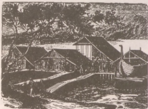
* Habitations sur pilotis des Arfakis, du havre de Doréi (Nouvelle-Guinée).
